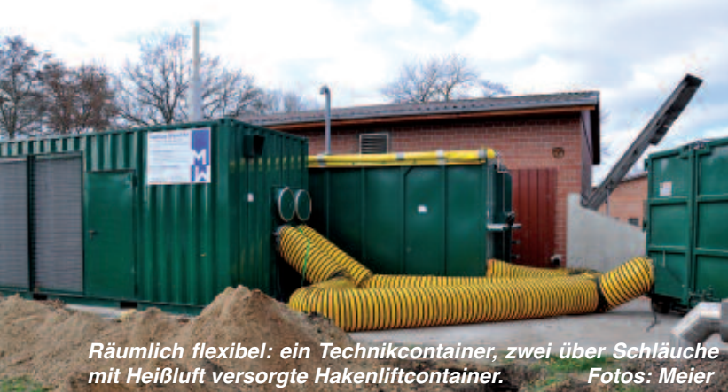
Das Satelliten-Bhkw versorgt das Wärmenetz einer Siedlung, deshalb benötigte der Technikcontainer der Trocknung besonderen Schallschutz.
